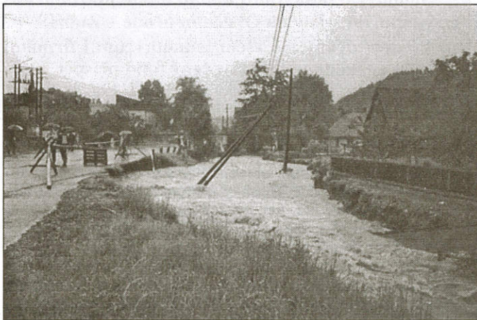
Podemletá silnice nad Domem služeb
