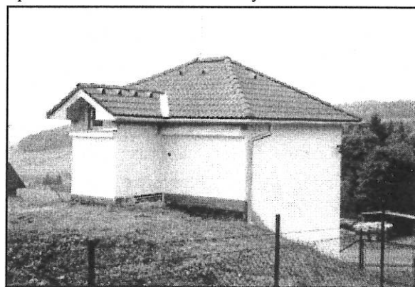
Rekonstrukce střešky vodojemu na Starém Zubří dokončena.
